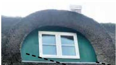
Ad.8.9 Foto af tagkvist med spejl og inddækning i zink.
